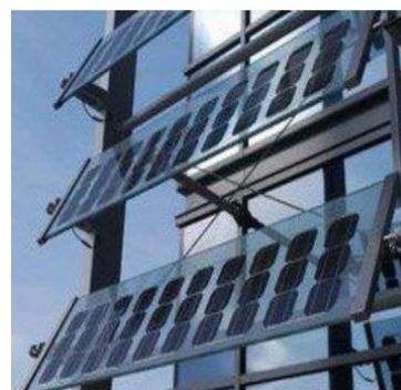
شكل (4) نظام كاسرات متحركه بالطاقة الكهرضويه
